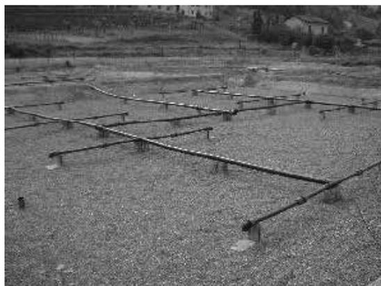
La configurazione di questi sistemi è del tutto simile a quelli a flusso sommerso orizzontale. La differenza consiste nel fatto che il refluo da trattare scorre verticalmente nel medium di riempimento (percolazione) e viene immesso nelle vasche con carico alternato discontinuo, mentre nei sistemi HF si ha un flusso a pistone, con alimentazione continua.
